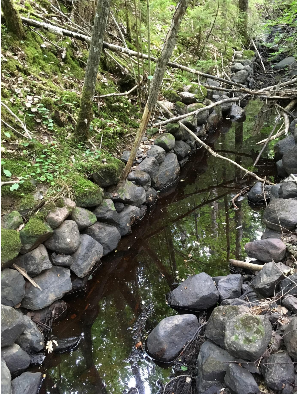
Bäcken mellan Långsjön och sjön Stärringen rätades ut i samband med sjösänkningar. Bäcken utgörs idag till större delen av en kanal som delvis är stensködd med kallmur.
